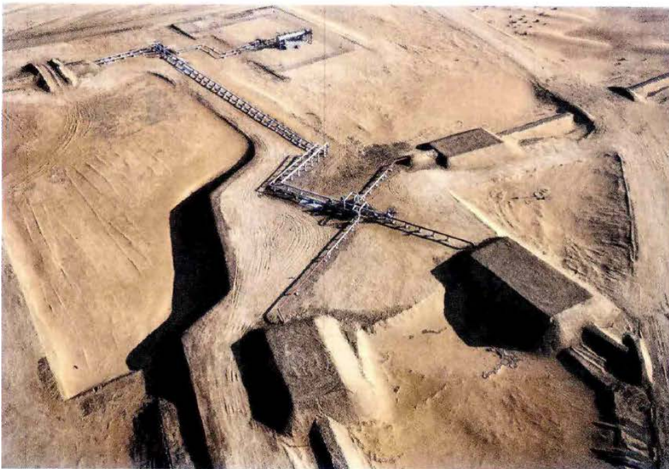
Un'intersezione di pipeline che conducono all'impianto di separazione del gas dal petrolio del giacimento saudita di Shaybah, situato nel deserto di Rub' al Khali.
